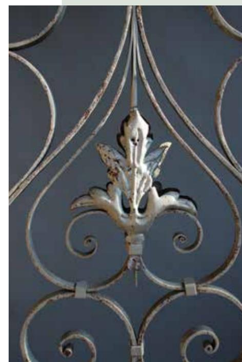
Détail du décor en tôle de fer « relevé sur le plomb » d'un des garde-corps de la façade du château, après décapage.
